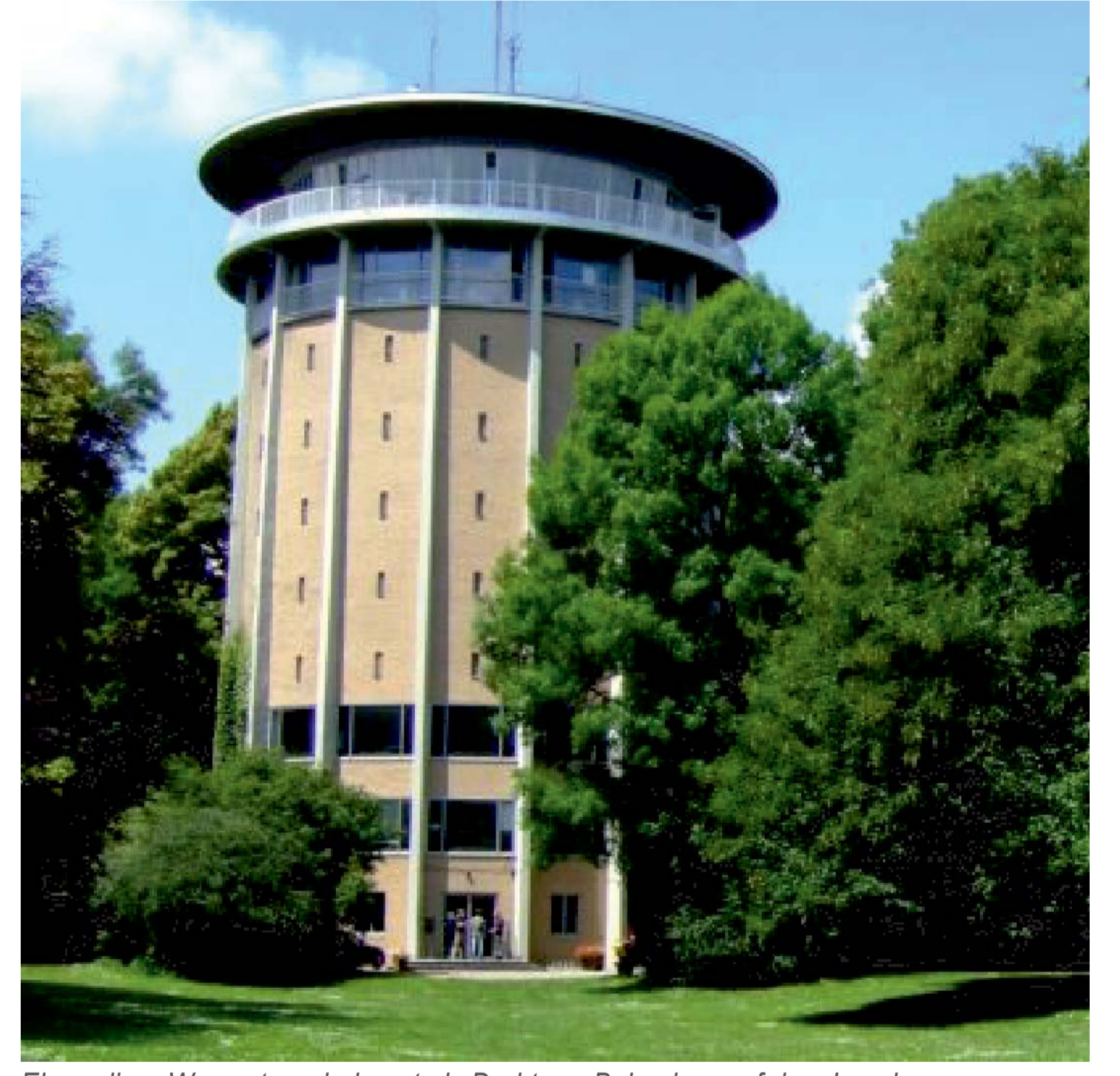
Ehemaliger Wasserturm bekannt als Drehturm Belvedere auf dem Lousberg
