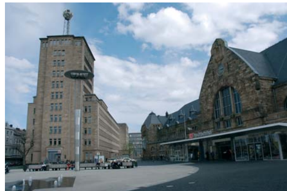
Stadt Aachen, Verwaltungsgebäude Bahnhofplatz
