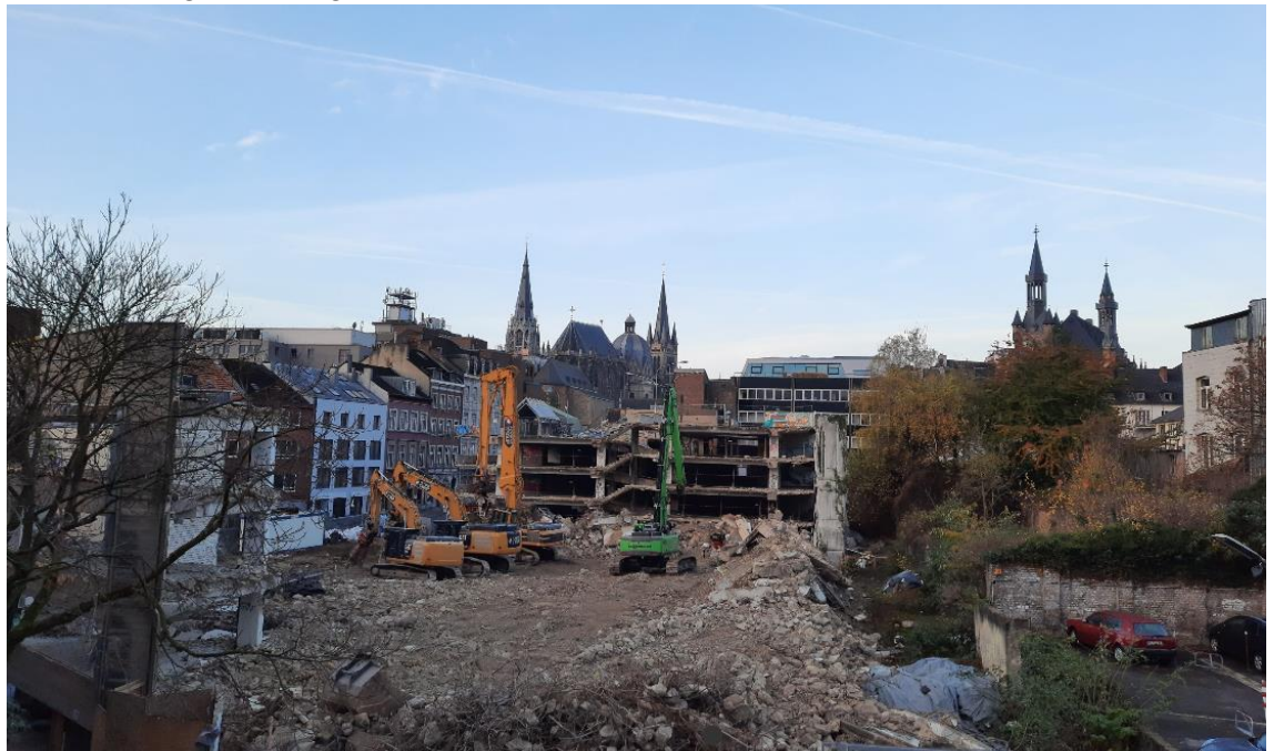
Abbildung 6: Abbrucharbeiten des ehemaligen Parkhauses Büchel (Quelle: SEGA)
