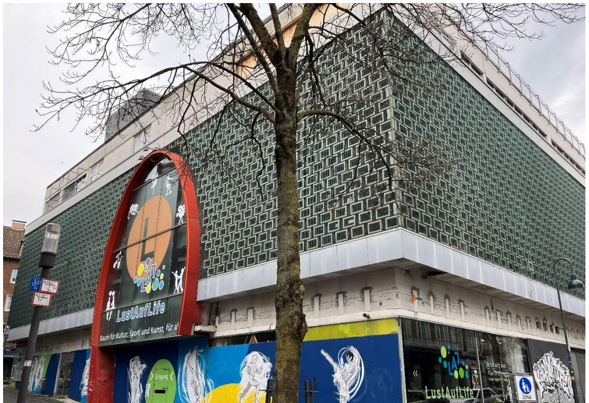
Abbildung 18: Ehemaliges Kaufhaus Horten (Quelle: NRW.URBAN, Aufnahme Februar 2025)
