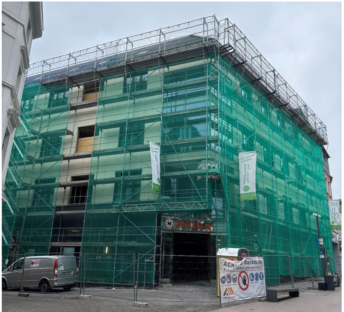
Abbildung 47: Im Umbau befindliches Geschäftshaus Großkölnstraße 68/70 (Quelle: NRW.URBAN, Aufnahme April 2025)
