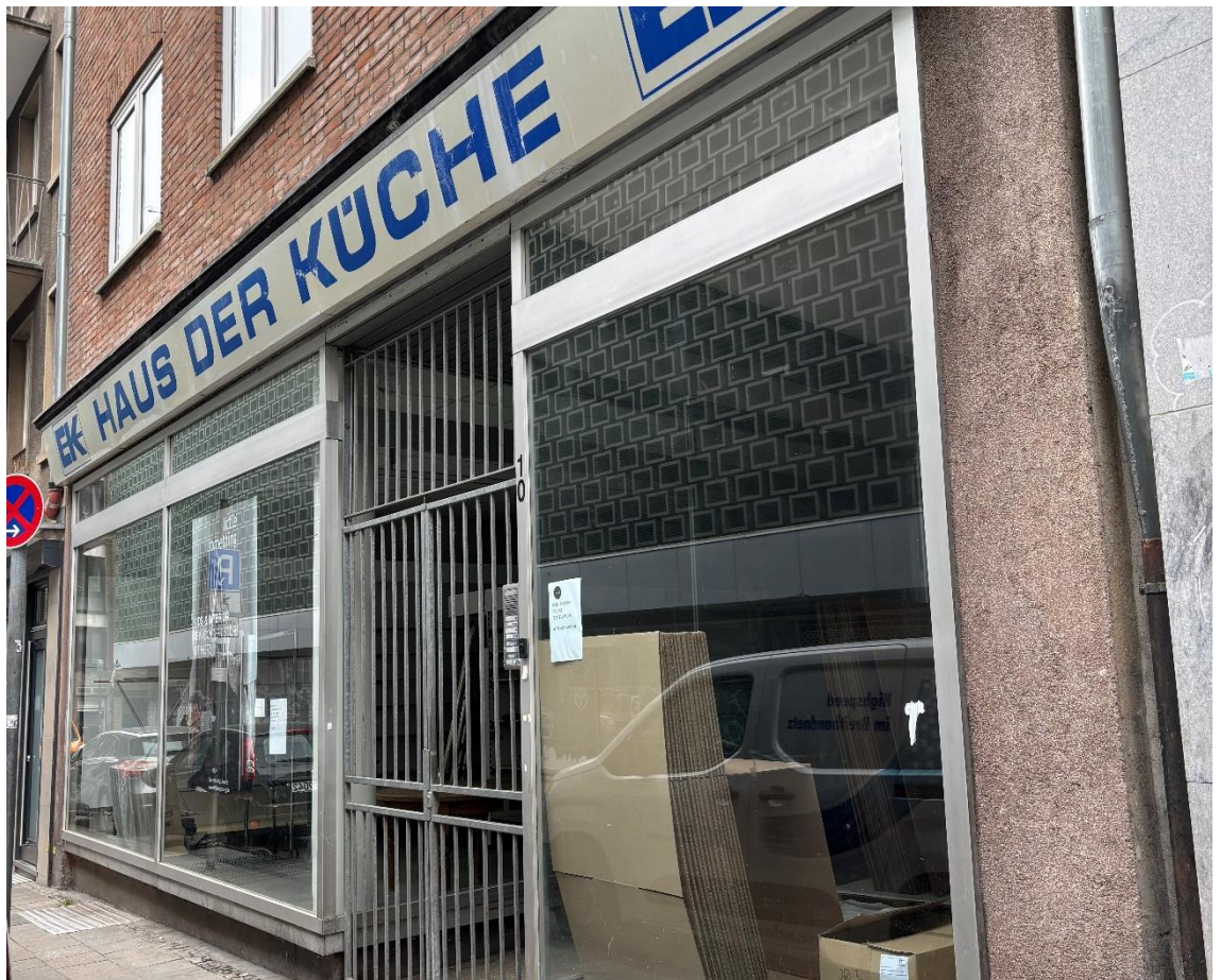
Abbildung 46: Leerstehendes Ladenlokal in der Mefferdatisstraße (Quelle: NRW.URBAN, Aufnahme April 2025)
