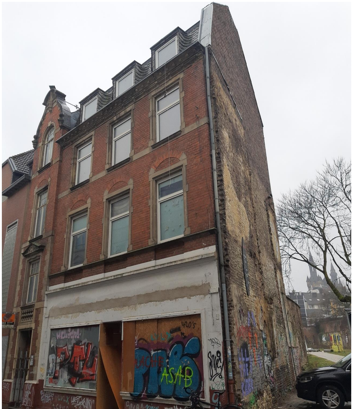
Abbildung 36: Gebäude Mefferdatisstraße 22 (Quelle: Stadt Aachen, Aufnahme Januar 2026)
