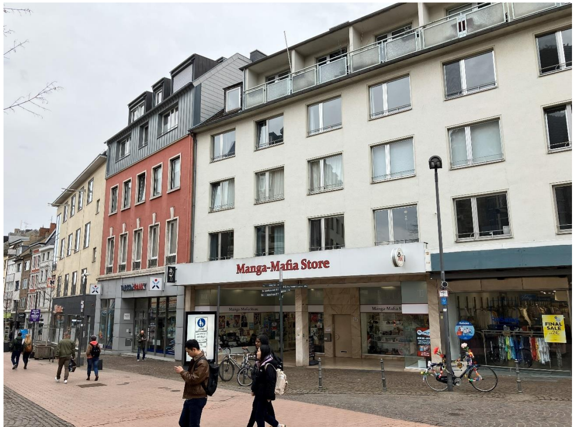
Abbildung 62: Großkölnstraße (Quelle: NRW.URBAN, Aufnahme Februar 2025)
