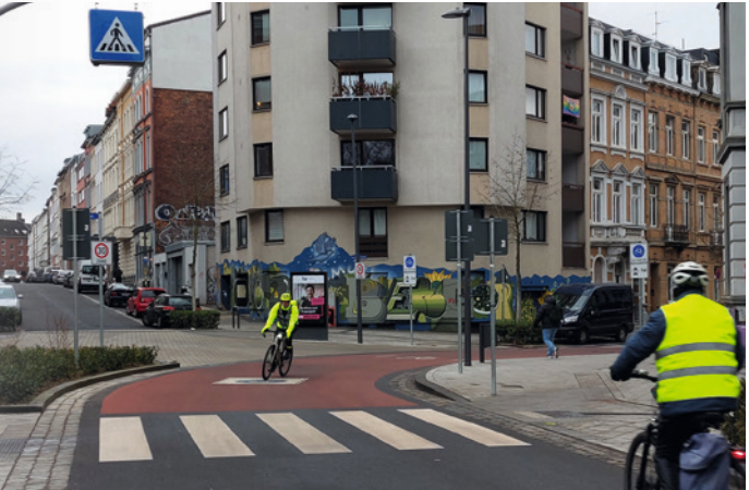
Abknickende Vorfahrt auf der umgestalteten Fahrradstraße an der Kreuzung Bismarckstraße, Schlossstraße, Rehmannstraße (© Stadt Aachen)
