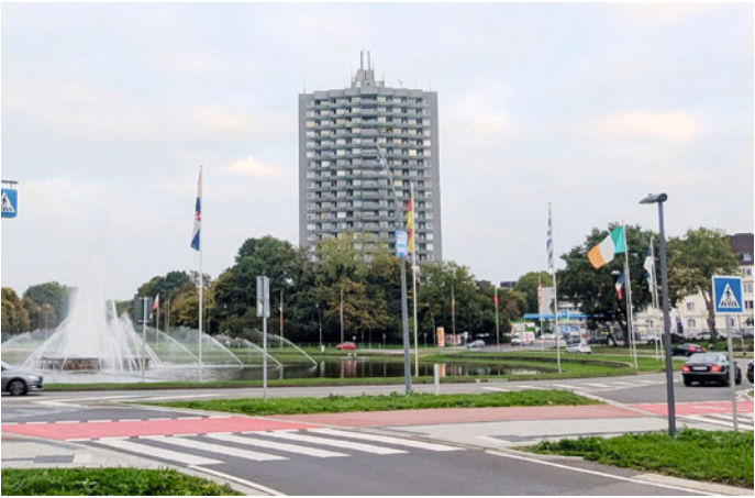
Sanierte Fahrbahnoberflächen am Europaplatz (© Stadt Aachen)
