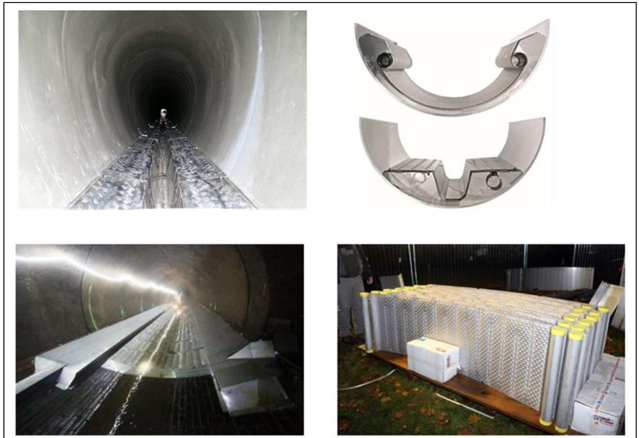
Abbildung 60: Abwasserwärmetauscher (Bildquelle: Fa. Uhrig (oben), Stadtwerke Aachen (unten))
