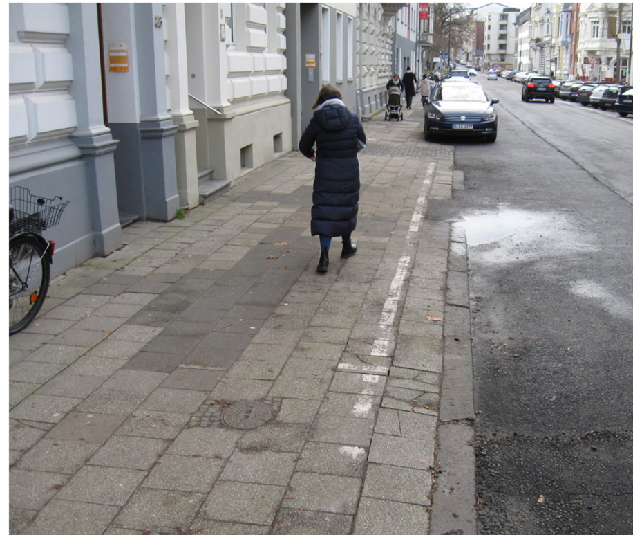
Südlicher Gehweg zw. Neumarkt und Goffartstr.
