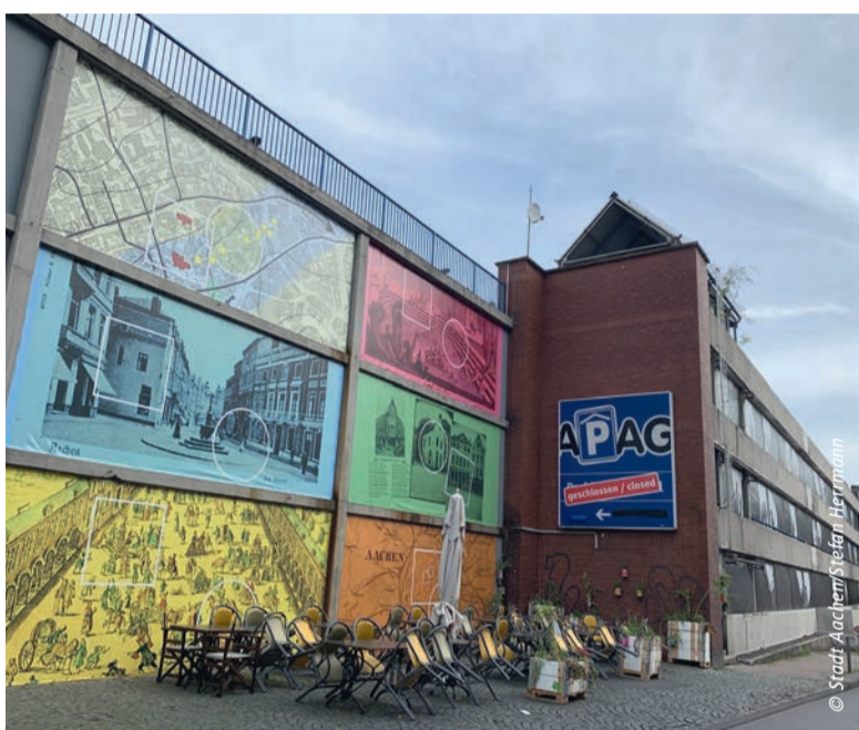
Stadt machen am Büchel: Richtig Fahrt aufgenommen hat eines der prominentesten Stadtentwicklungsprojekte Aachens. Kommendes Jahr wird das Parkhaus abgerissen. Dort entsteht dann ein pulsierendes Altstadtquartier.
