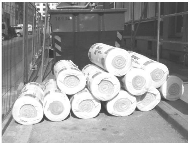
Dämmmaterial für eine Dachsanierung
