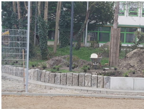
Die Böschung wird mit Winkelstützen und Natursteinen abgefangen
