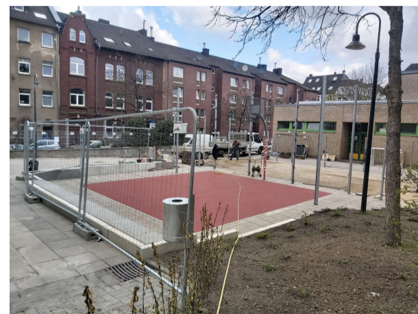
Und der Tartanbelag für das Streetballfeld eingebaut
