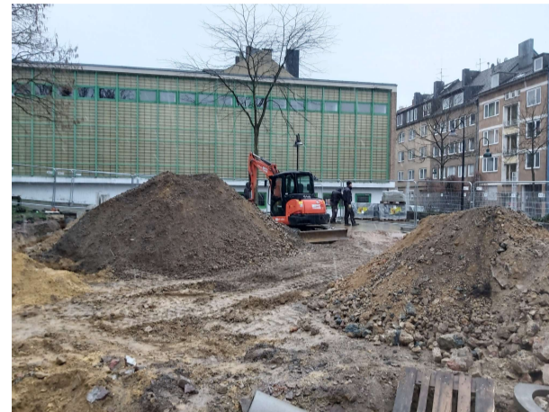
Damit die Spielfelder für Fußball und Streetball eben sind, muss der Boden abgetragen werden
