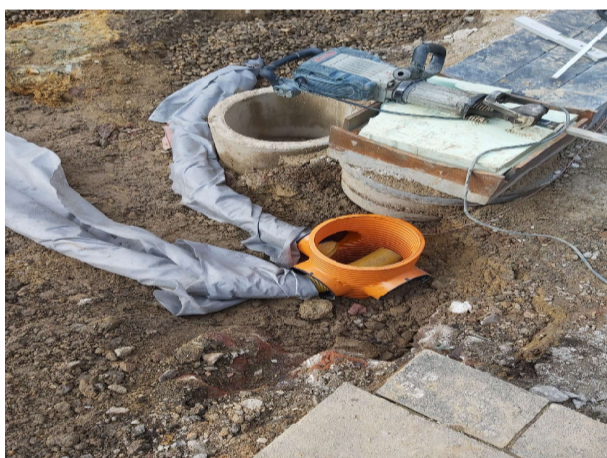
So wurde kurzfristig eine Drainage eingebaut
