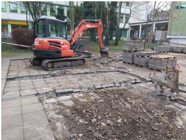
Auf dem unteren Schulhof werden Betonplatten entfernt, um Spielfelder anzulegen
