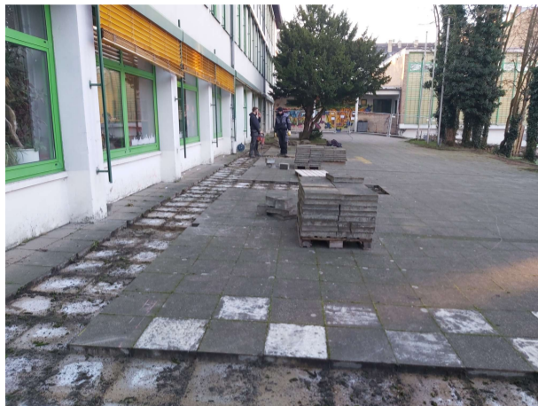
Auf dem oberen Schulhof werden Betonplatten entfernt, um später Hecken zu pflanzen
