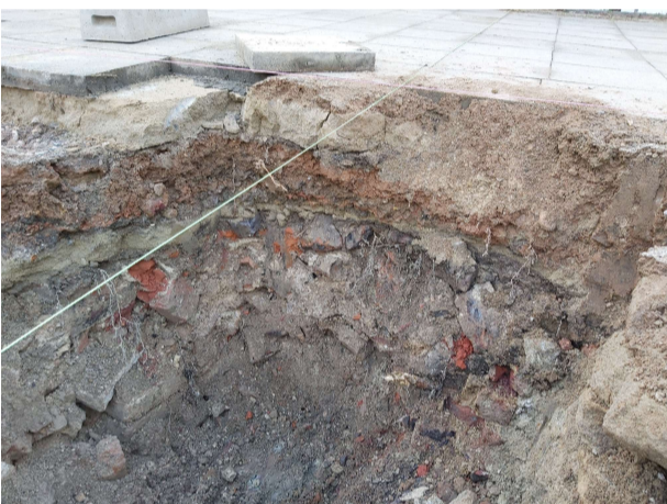
...ein altes Schulgebäude, dessen Grundmauern aus Ziegelsteinen, ausgestemmt werden mussten
