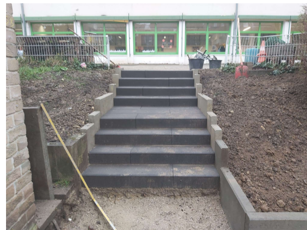
Die neue Treppe verbindet nun den unteren und oberen Schulhof
