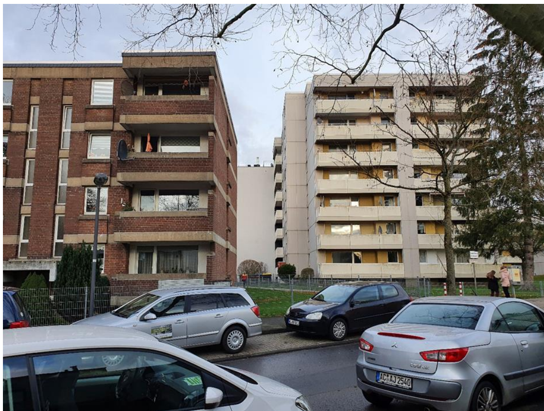
Stettiner Straße, nördliche Bebauung, Driescher Hof
