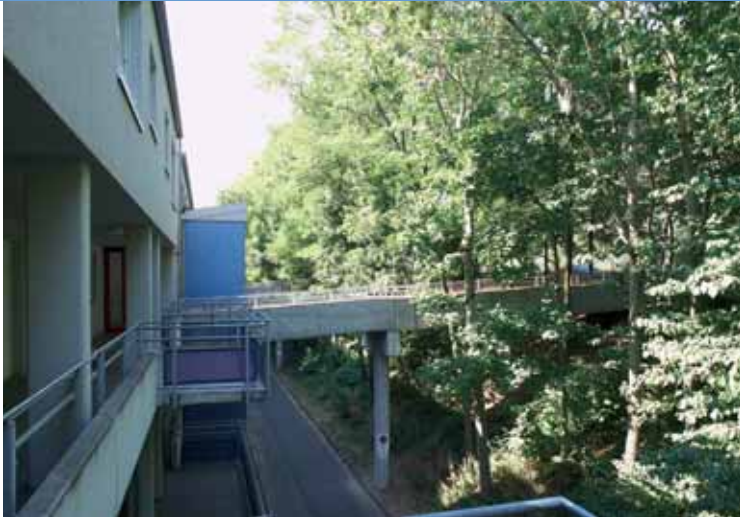
Niveaugleiche Brücken erschließen das erste Obergeschoss.
