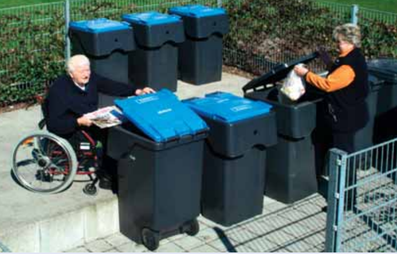
Ein gut geplanter Müllcontainerplatz: Die erhöhte Anfahrt macht das Öffnen der Deckel leicht für alle. Arnsberg-Unterhüsten
