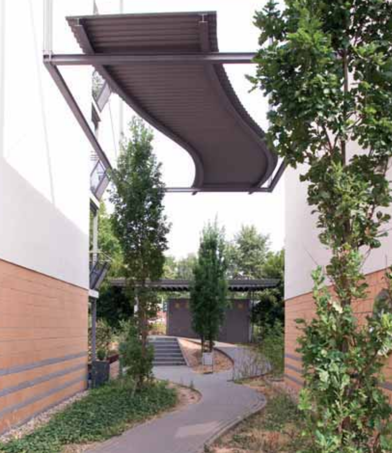
Beispiel einer Rampe in Kombination mit einer Treppe. Lippeweg, Hückelhoven
