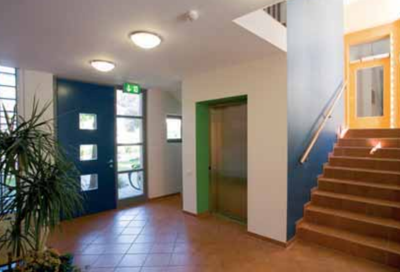
Ausreichender Bewegungsraum vor dem Aufzug vereinfacht den Ein- und Ausstieg. Runde Straße, Rheine
