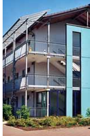
Der Wetterschutz am Treppenaufgang als architektonischer Blickfang.
