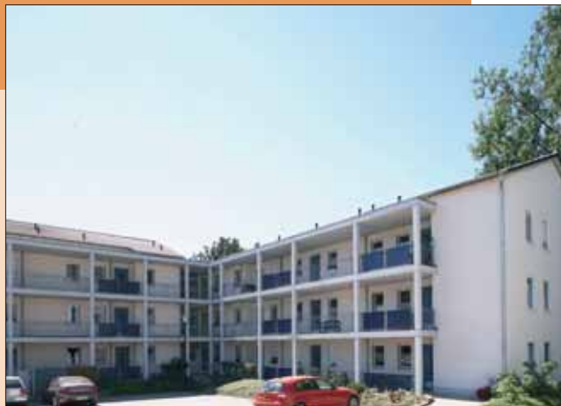
Laubenganghäuser im 2. Bauabschnitt.
