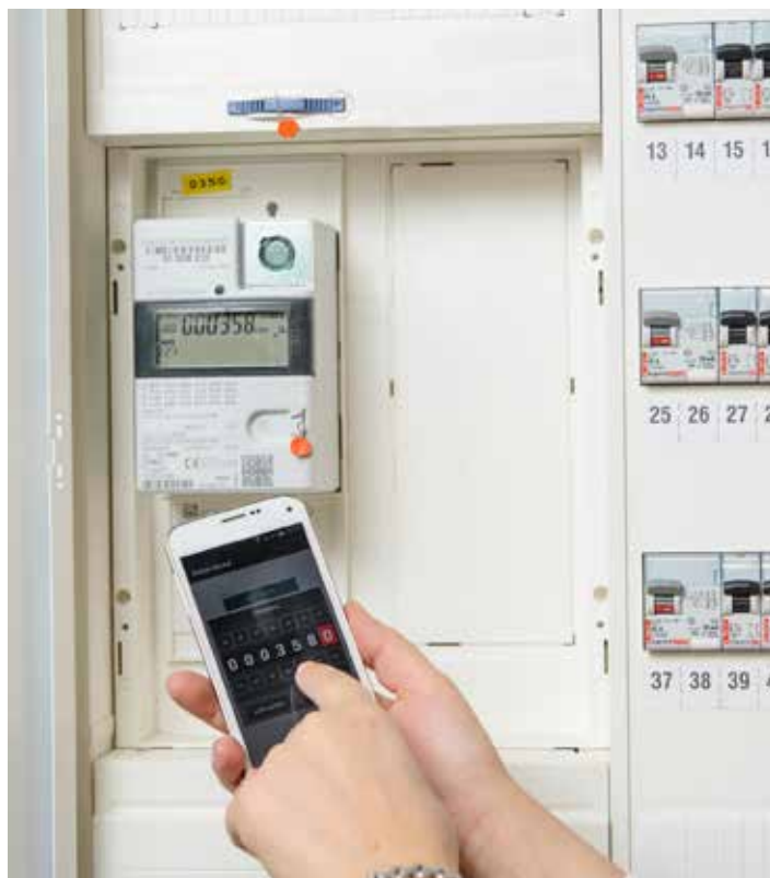
„Smart Meter“ sind intelligente Zähler mit vielen Funktionen.
