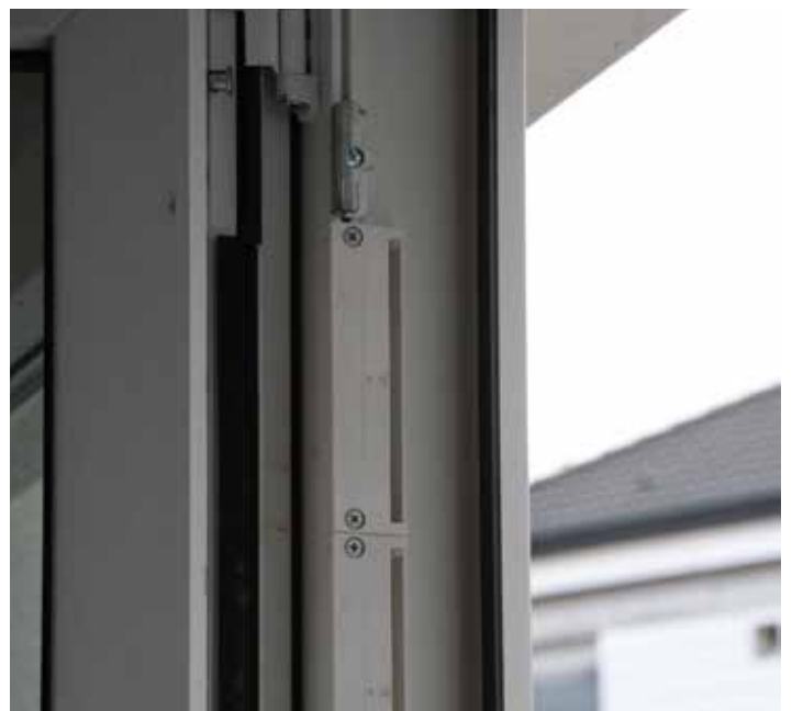
Fensterfalzlüfter: Die Klappe im Rahmen reagiert auf Winddruck.
