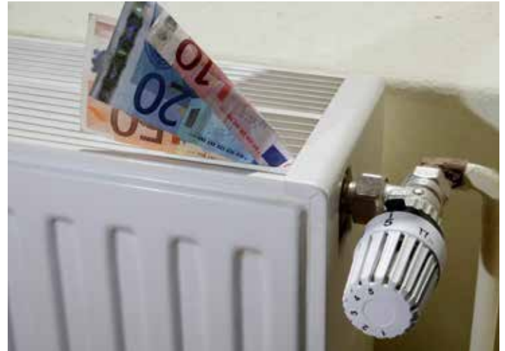
Verbeizen Sie nicht Ihr Geld: Thermostatventil auf „5“ bedeutet, dass der Raum dauerhaft auf ca. 23° C erwärmt wird.
