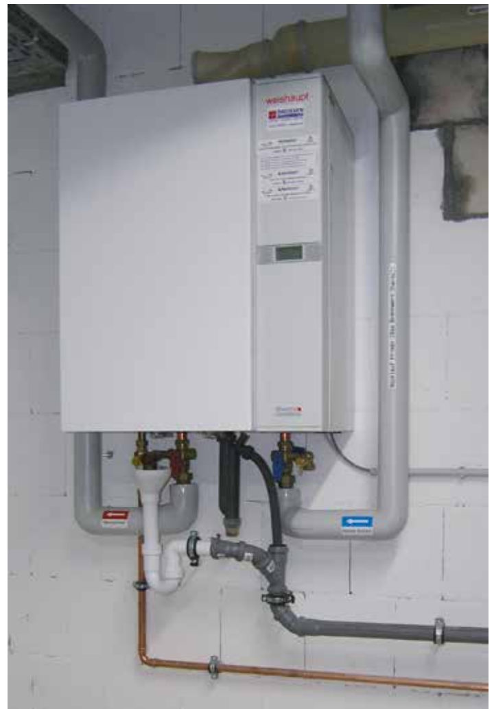
Gas-Brennwertkessel, hier als wandhängendes Gerät
