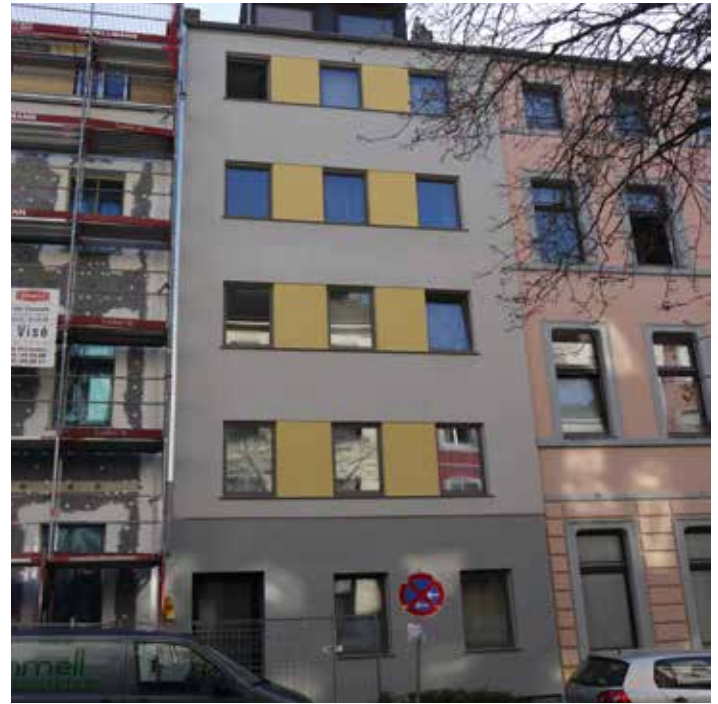
Nach der Sanierung: Geringer Energieverbrauch, moderne Fassade
