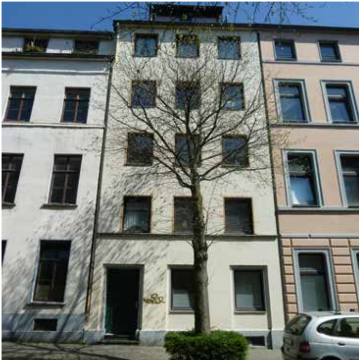
Vor der Sanierung: Hoher Energieverbrauch, Modernisierungsbedarf
