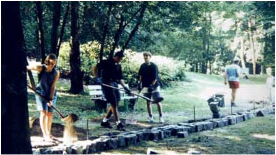
Jugendliche bei Wegebauarbeiten 1992
