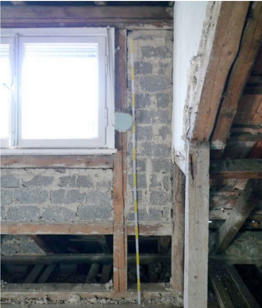
Vermutlich historische Gaube mittlerer Größe Innenansicht Aus: Studie frye architekten
