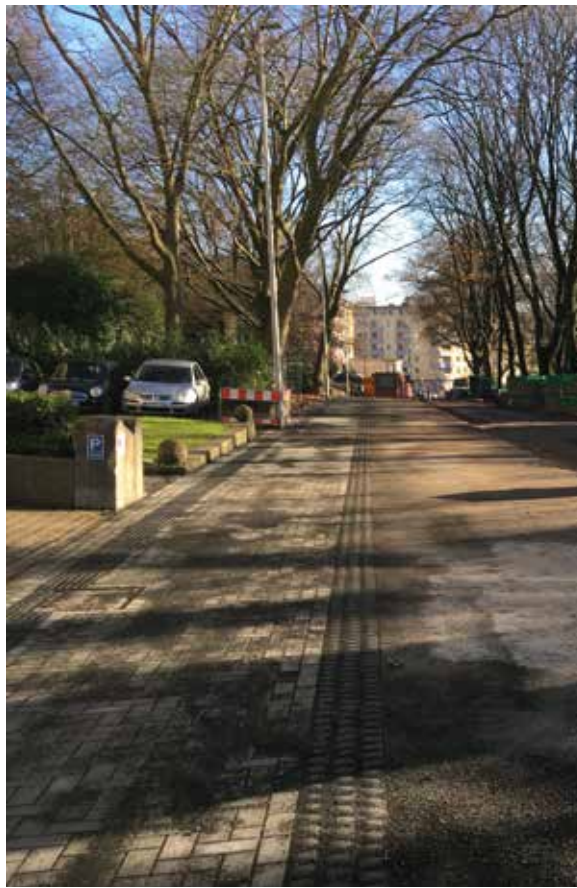
Abbildung 23: Baufortschritt auf der Ludwigsallee (Stand November 2021). Der Asphaltweg wurde bereits angelegt.
