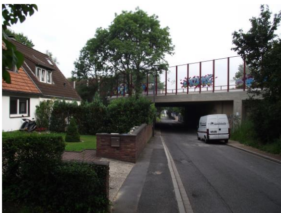
Abbildung 16: Lärmschutzwand in Aachen-Laurensberg / -Richterich
