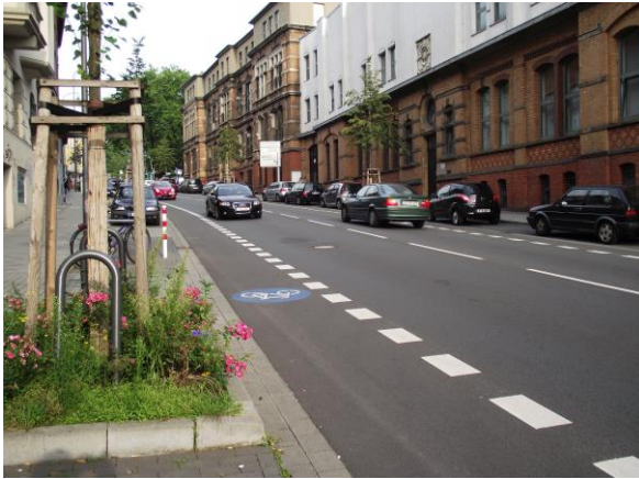
Abbildung 17: Boxgraben 1. Bauabschnitt – neuer Fahrbahnbelag
