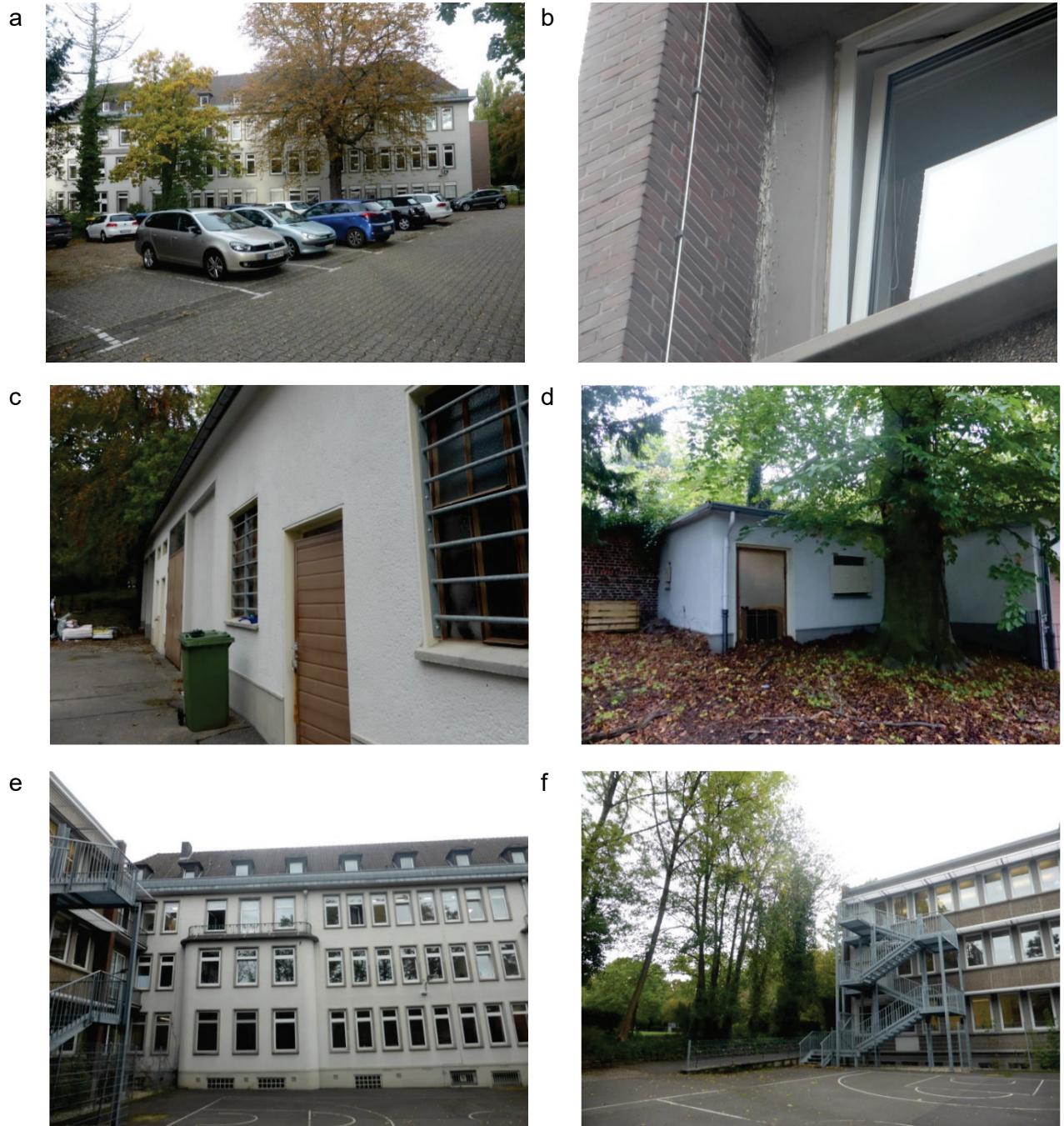
Abbildung 6: Gebäudestrukturen im Eingriffsbereich von außen
