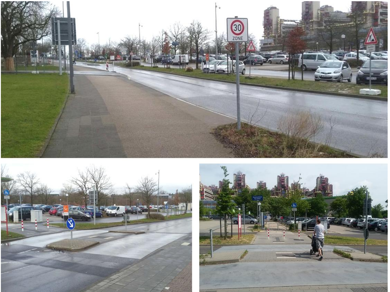
Bild 5: Bilder der Kullenhofstraße und Fußgängerquerung (derzeitiger Bestand)
