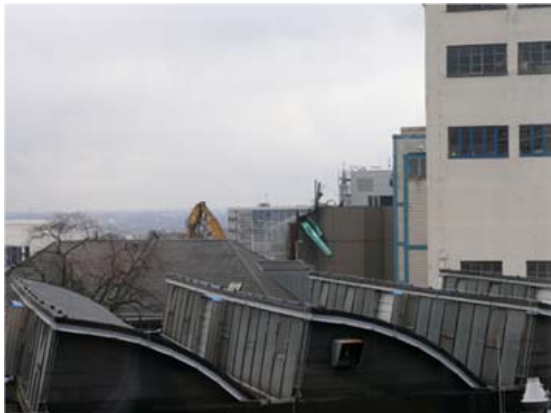
Abriss der alten Heizzentrale auf dem RWTH-Gelände
