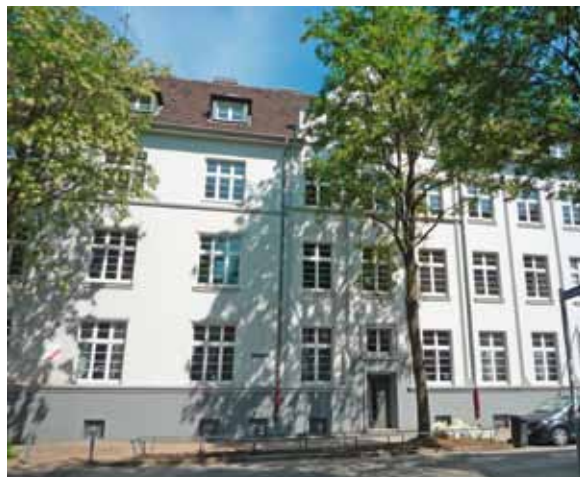
links: Energetische Sanierung Kindergarten Höfchensweg
