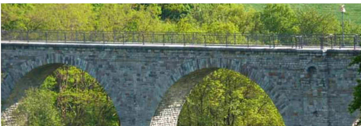
Viadukt Brand/ Vennbahnweg
