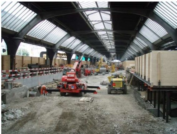
Bau unterirdischer Durchgangsbahnhof
