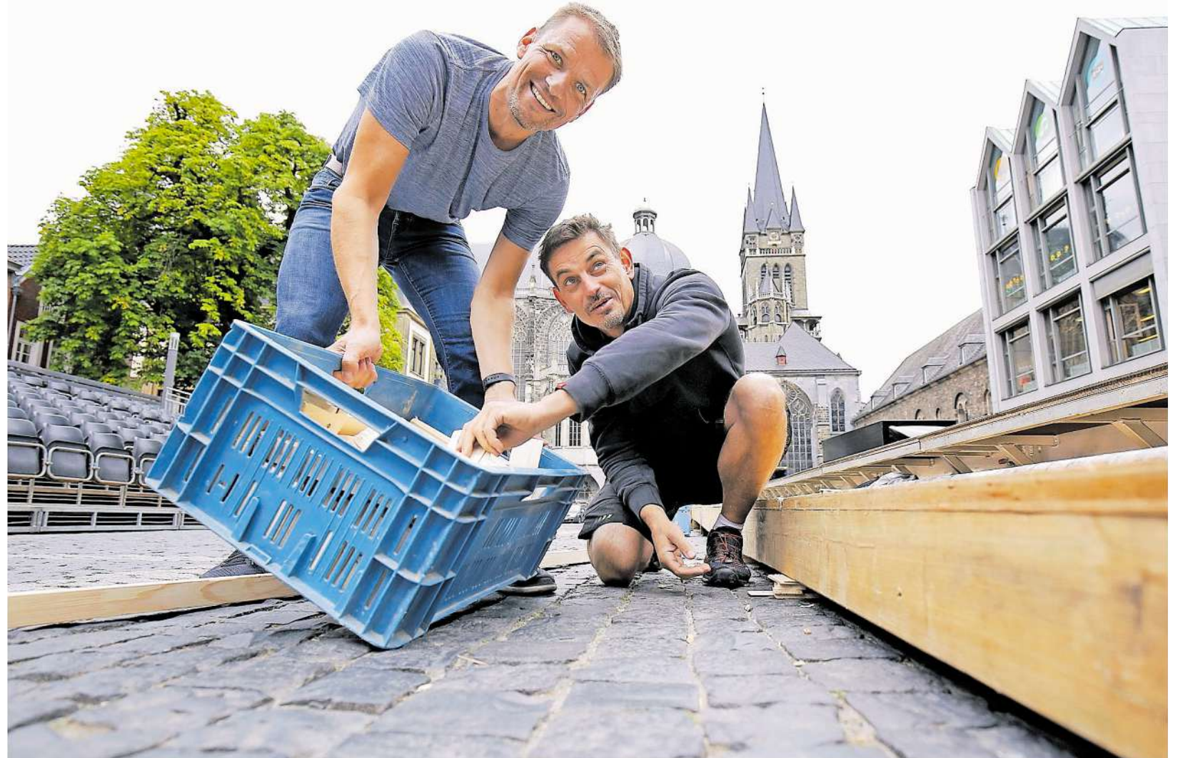
Feinjustierung am Anlaufsteg: Michael Leers (links, Alemannia Aachen) und Anlagenbauer Marc Osenberg wissen genau, wo Holzplättchen unterlegt werden müssen. FOTO: WOLFGANG BIRKENSTOCK
