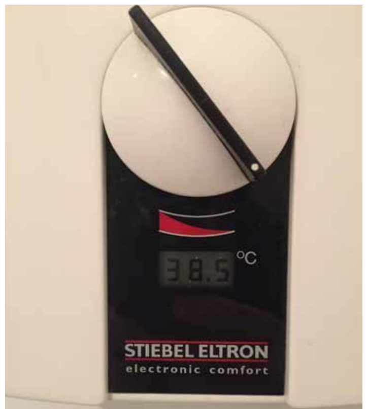
Elektronisch geregelter Durchlauferhitzer: Hier kann die Wassertemperatur genau eingestellt werden.
