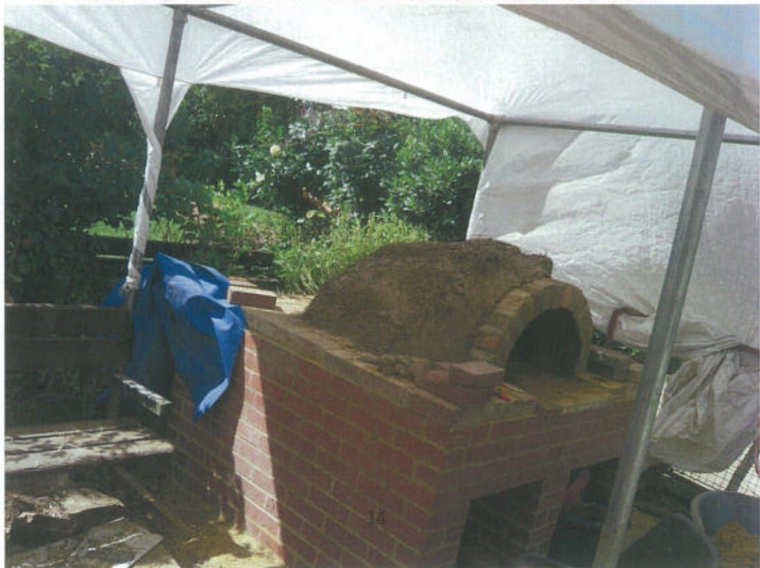
Abbildung 6: London Sommer 2013 Calthorpe Project Baustelle Lehm pizzaofen
