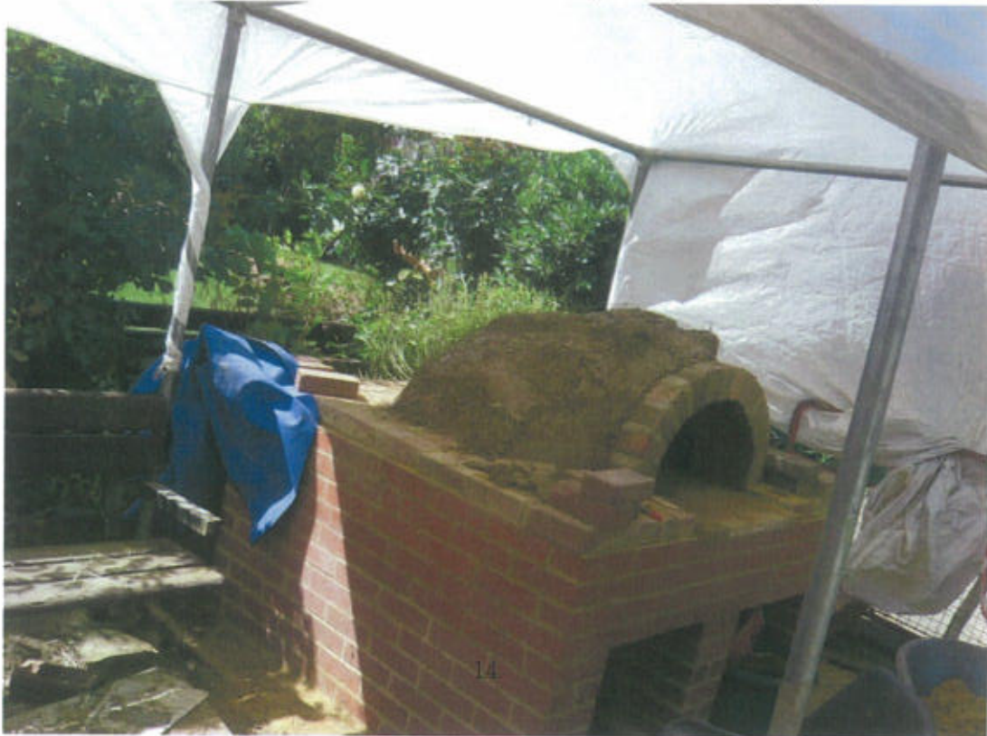
Abbildung 6: London Sommer 2013 Calthorpe Project Baustelle Lehm pizzaofen
