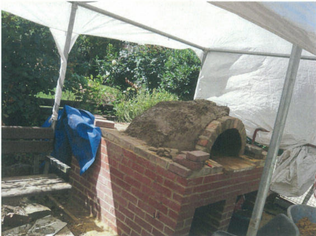
Abbildung 6: London Sommer 2013 Calthorpe Project Baustelle Lehm pizzaofen
