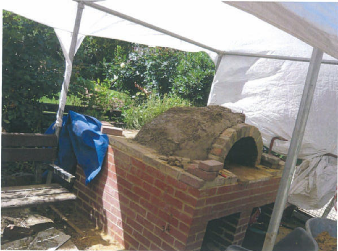
Abbildung 6: London Sommer 2013 Calthorpe Project Baustelle Lehm pizzaofen
