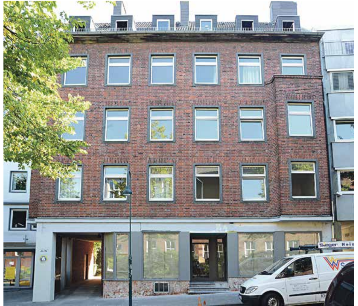
Studierende statt Döner: Diese ehemalige Imbissbude wird zur Studi-Bude umgebaut.
