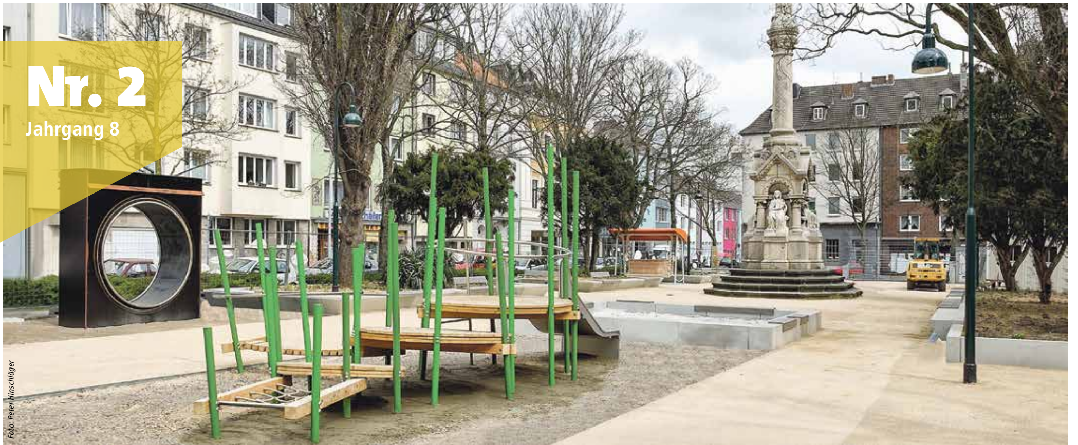
Der Rehmplatz: Seine Umgestaltung war ein wichtiger Baustein des Programms „Soziale Stadt Aachen-Nord“.
