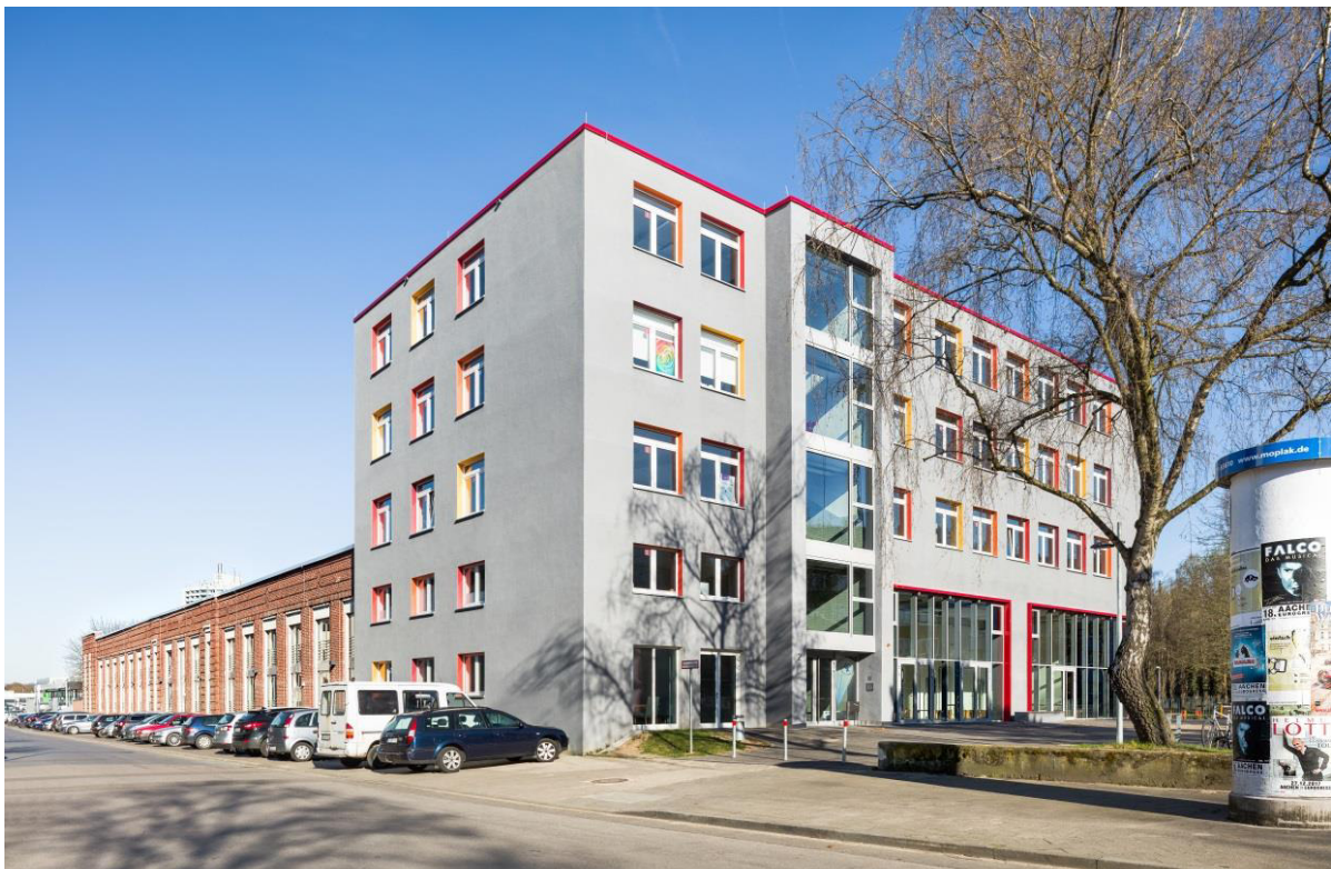
Das alte Straßenbahndepot der ASEAG wurde im Zuge der Sozialen Stadt Aachen-Nord zu einem sozialen und kreativen Zentrum für den Stadtteil ausgebaut (Foto: Peter Hinschläger)
