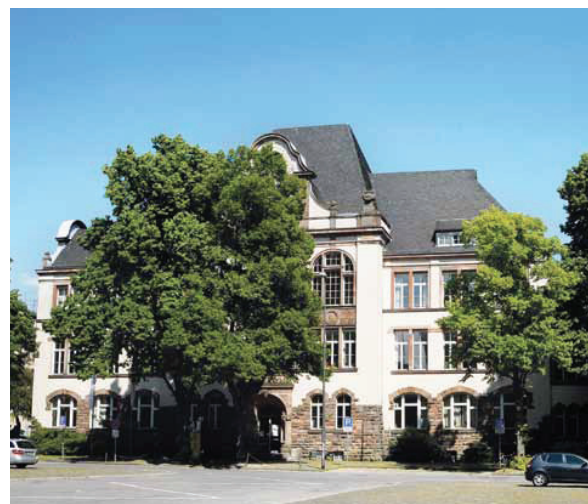
Ein markantes Gebäude in Aachen Nord: die Musikschule am Blücherplatz.
