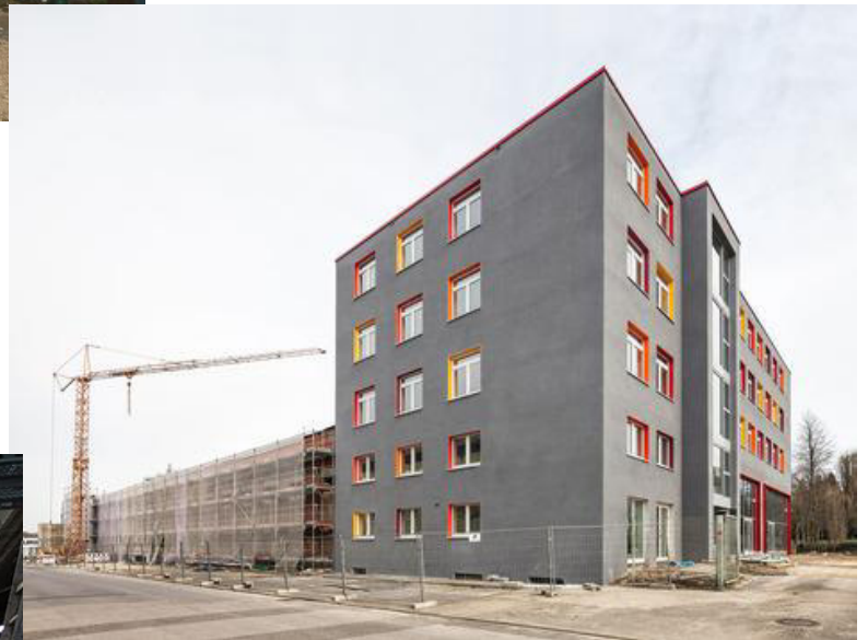
Der fertige Kopfbau mit eingerüsteter Halle (Foto: Peter Hinschläger).
