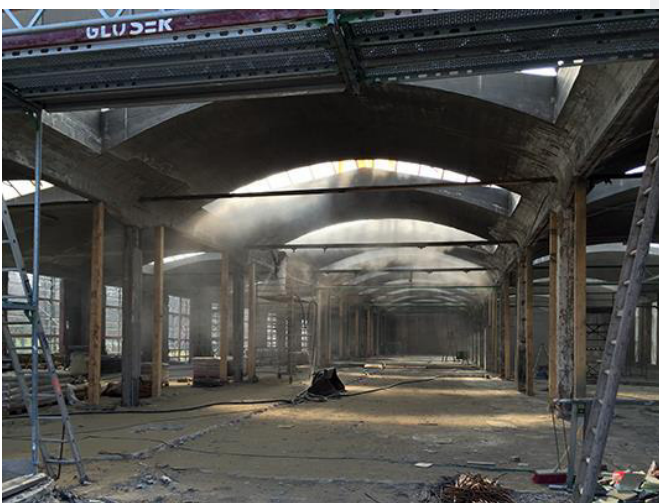
Bauarbeiten in der Halle (Foto: Peter Hinschläger).
