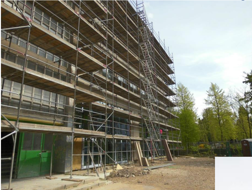
Der eingerüstete Kopfbau (Foto: Stadtteilbüro).
